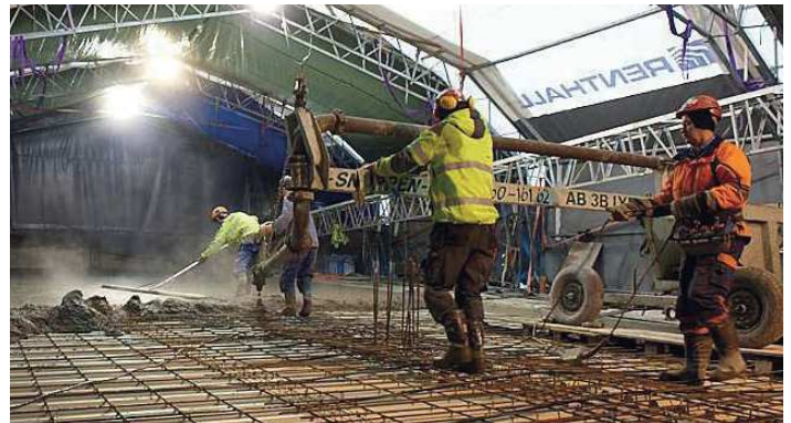
Vid pågjutning av större ytor planeras etappavstängning.
