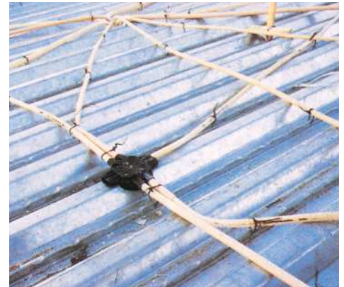
El- och vissa vvsinstallationer kan gjutas in på traditionellt vis. Infällt: Plåtändar tätas med profilskena tätband, dessa medlev.
